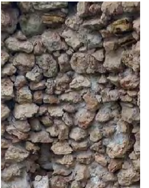
3. Juntado entre mampuestos degradado y algunos mampuestos perdidos.
