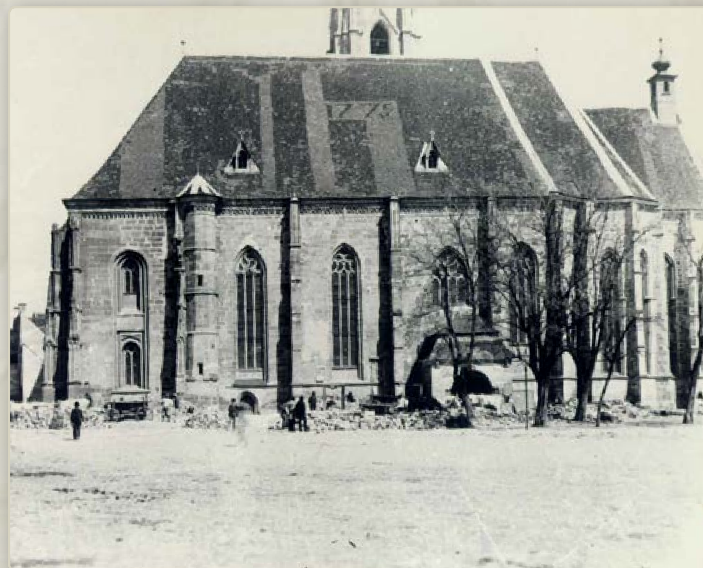
A templom körüli épületek bontása, 1886 körül | Demolarea clădirilor din jurul bisericii în jurul anului 1886 | Demolition of the buildings around the church around 1886
