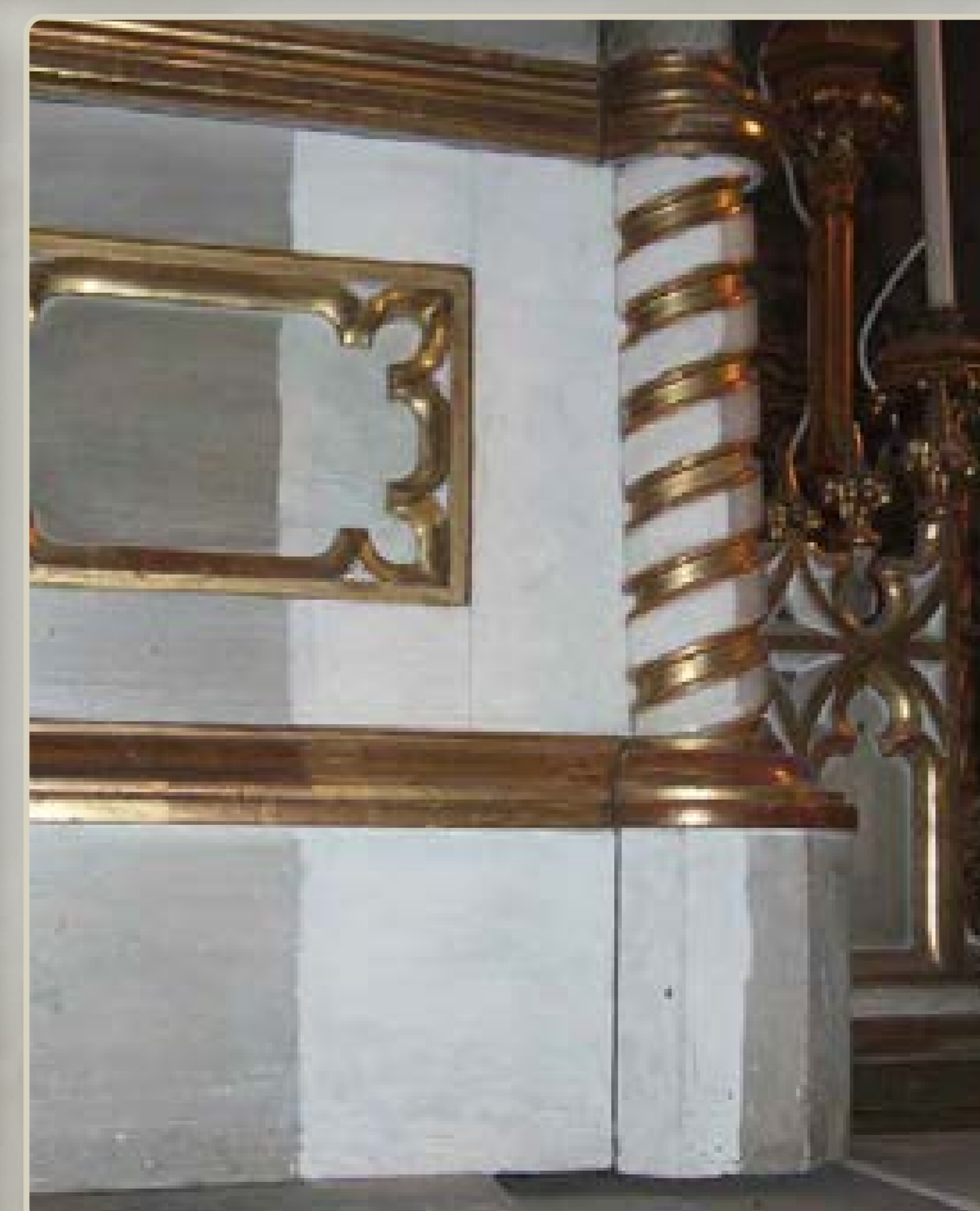
Tisztítási próba az oltár felületén. A vastag, szürke szennyeződések, lerakódások eltávolítása | Probă de curățire pe suprafața altarului. Înlăturarea depunerilor aderente groase și gri | Test cleaning on the surface of the altar. Removal of thick, grey, dirt and deposits.
